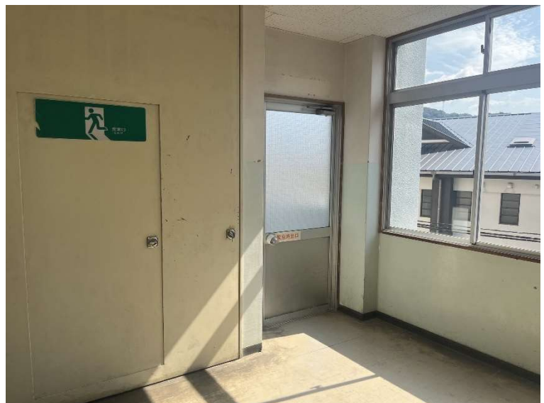
第3教棟 非常時出口
